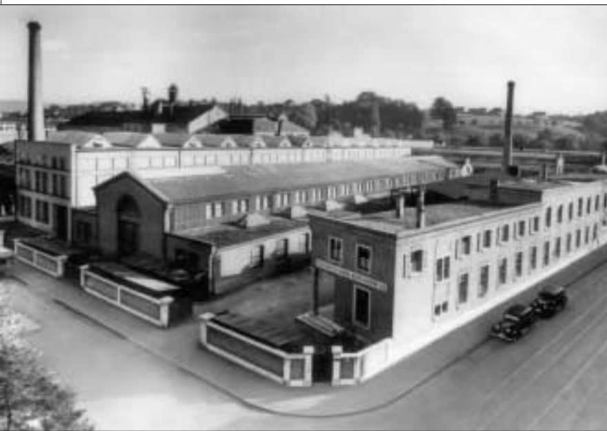
Geschützt: Maschinenhalle Nr. 8 (Mitte) auf dem Gundeldinger Feld
